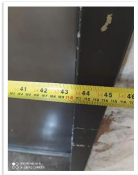
escalones es de varias como lo es en el caso de la unidad, la longitud de un descanso intermedio no debe ser inferior al ancho no obstruido de la vía más ancha y como el ancho de la vía más ancha es de 1440mm, se cumple con el requisito.
